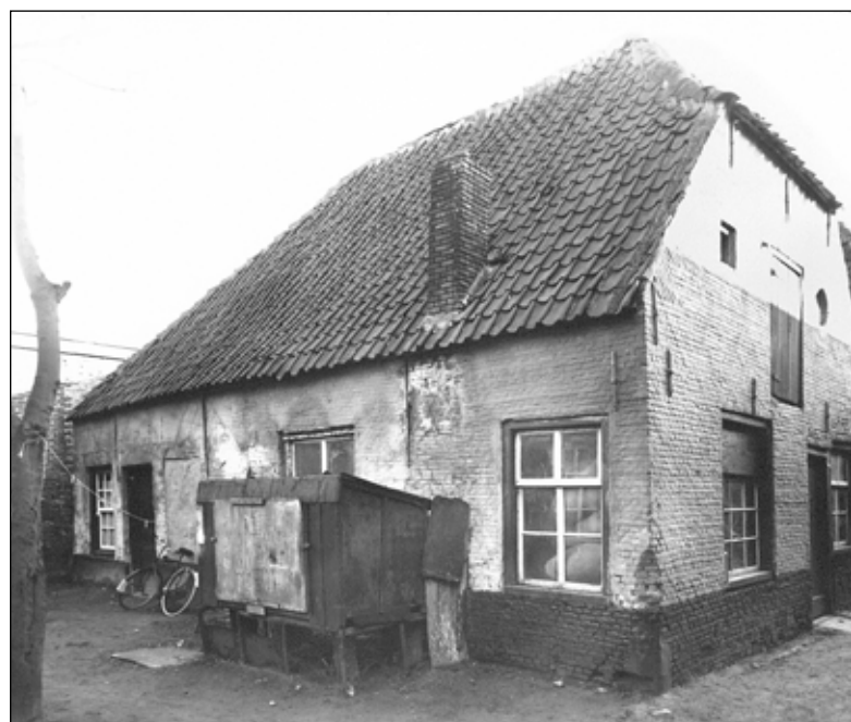
Het voormalige pakhuis in 1955 gezien vanaf de Winterdijk door het dammetje tussen locatie Aw 20 en 22. Let op de twee zadeldaken met wolfseinden, de verdieping met laaddeuren en lichtvensters; in al zijn eenvoud een voor Waalwijk bijzonder en ook wel voornaam bouwwerk. Het huisje met de fiets ervoor is de tot in 1960 bewoond gebleven woning.
