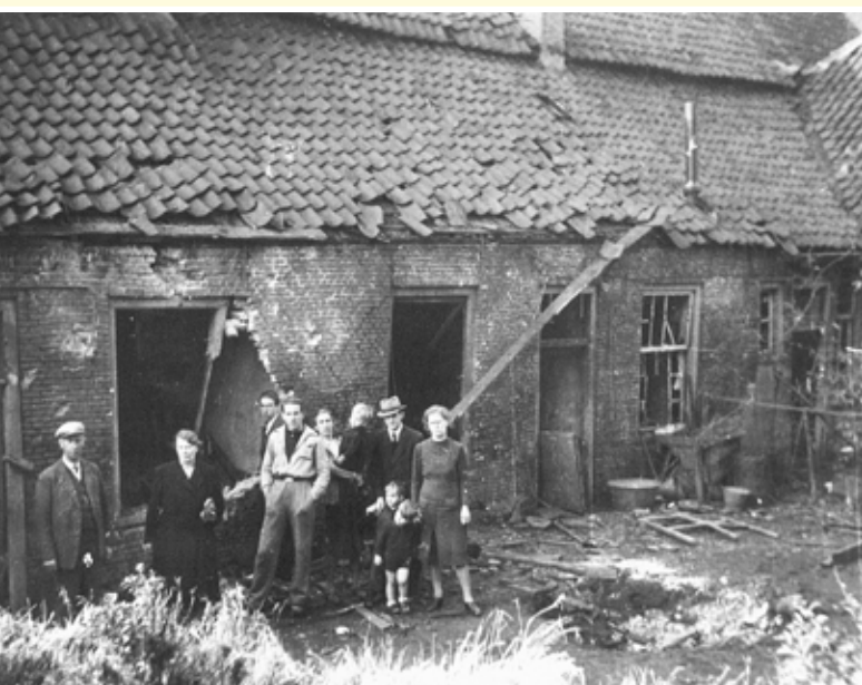
Na de granaatinslag in WO II resteert dit van de smalle huisjes aan de oostkant van het noord- zuid lopende deel van locatie
