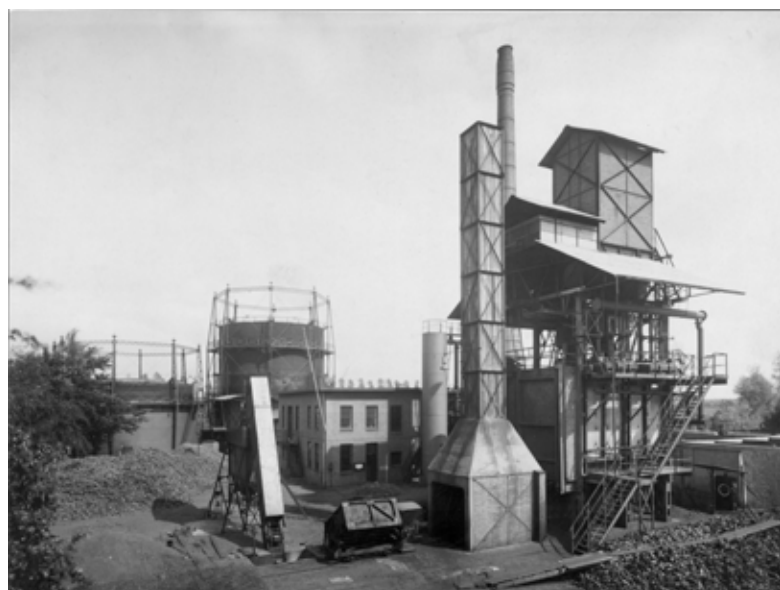
Het hart van de gasfabriek, de reductieoven, hier op een foto uit 1929. Links achter de ronde houders waarin het gas werd opgeslagen.
