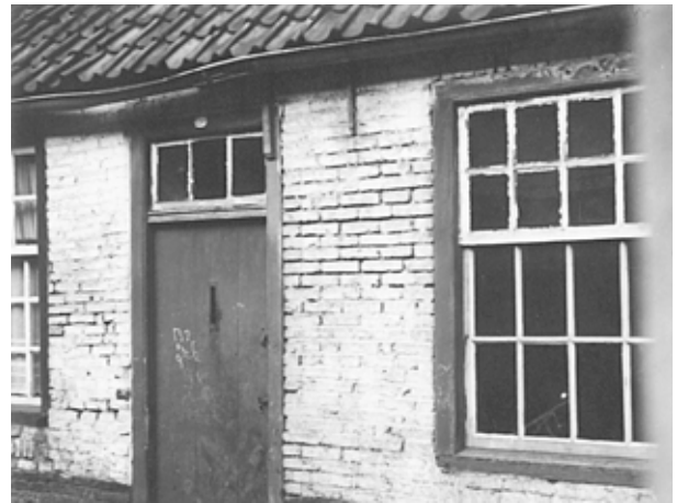
Damhuisje op locatie Bo 14, huisnummer 320 met toevoeging. De buitenmuur is halfsteens.
