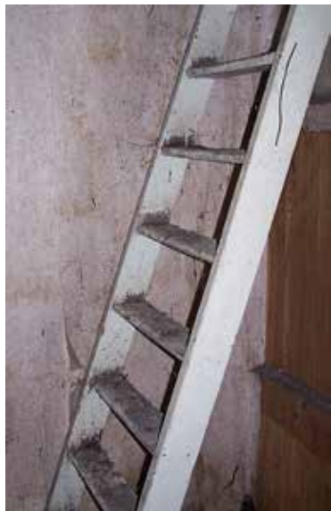
Een typisch steektrapje, hier naar de kapruimte van locatie Aw 11.
