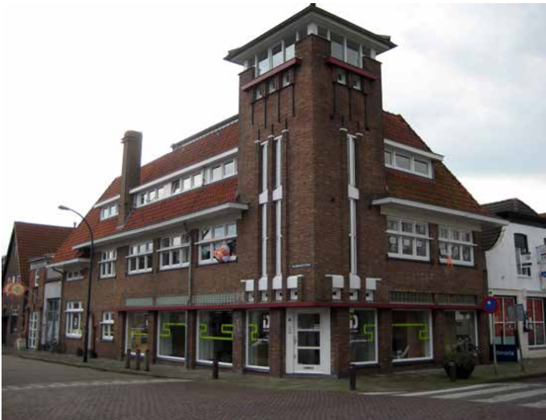
Het winkelpand met bovenwoning dat nu op deze locatie staat.
