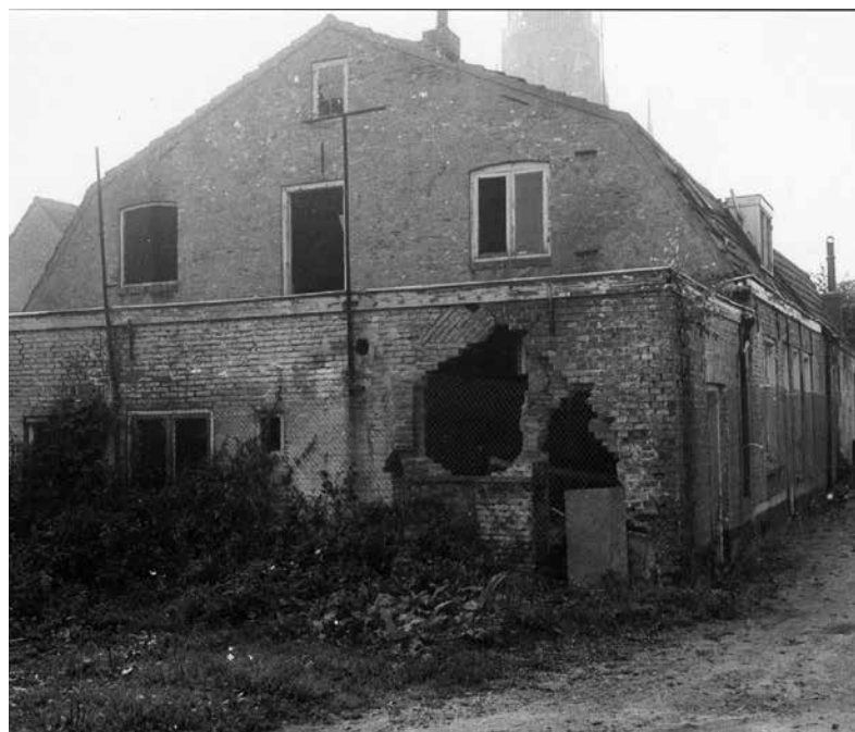
Twee opnamen, vlak voor de sloop in 1982, van de voor- en achterzijde van de panden Loeffstraat 69 en 69a (de damwoning A)
