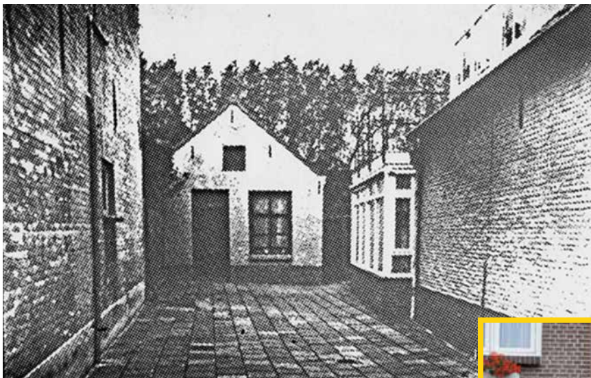
De nog oorspronkelijke woning achter in de dam tussen Grotestraat 11 en 15
