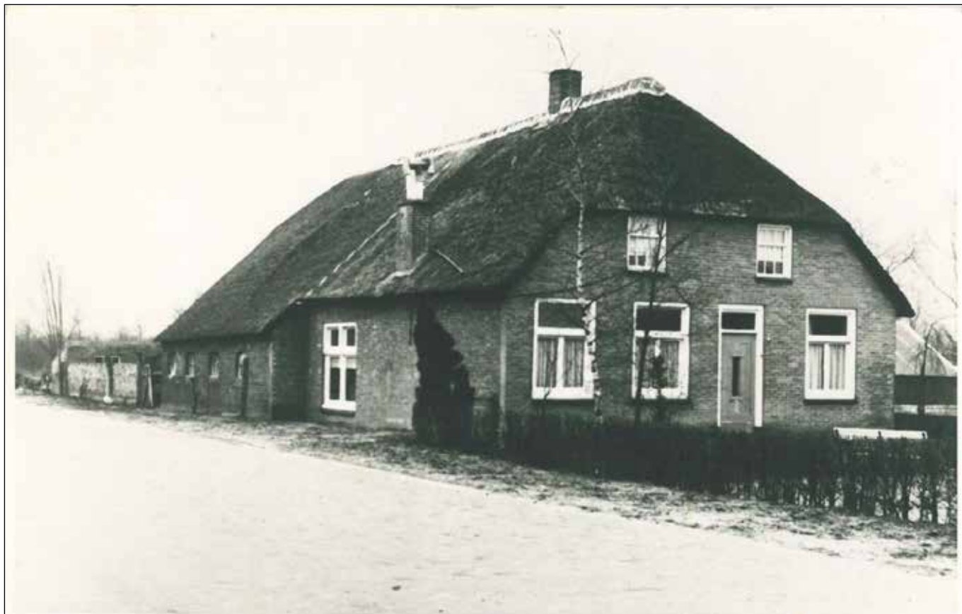
De boerderij Hoogeinde 56. Op de plaats van het inspringende raam in de linker zijgevel was de extra kamerwoning uitgebouwd. Het pand is gesloopt.
