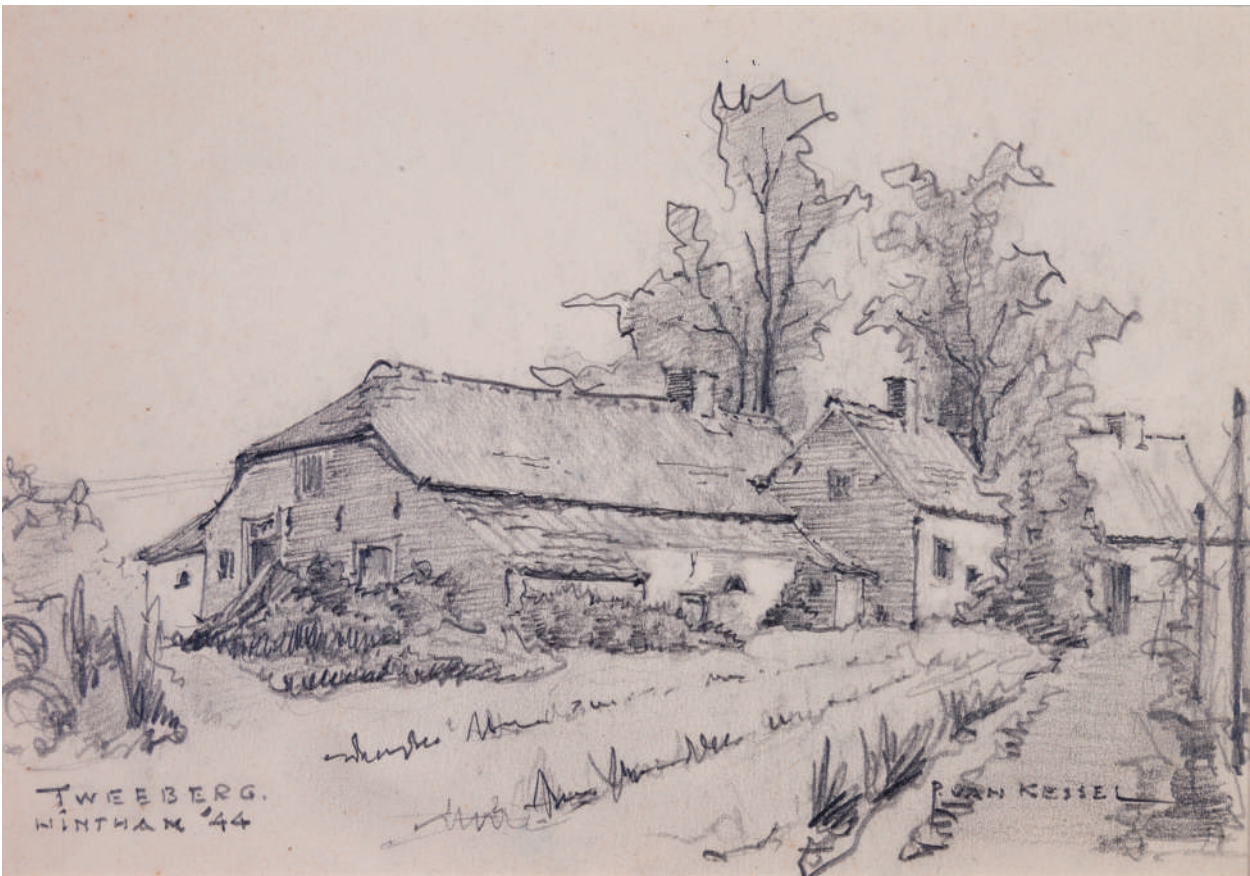
Rechtse dijk 6 (dus niet de Tweeberg) vanuit het noordoosten gezien. Getekend door Piet van Kessel, de vroegere Bossche stadsarchitect. Collectie: Stichting Bossche Prentenmuseum
