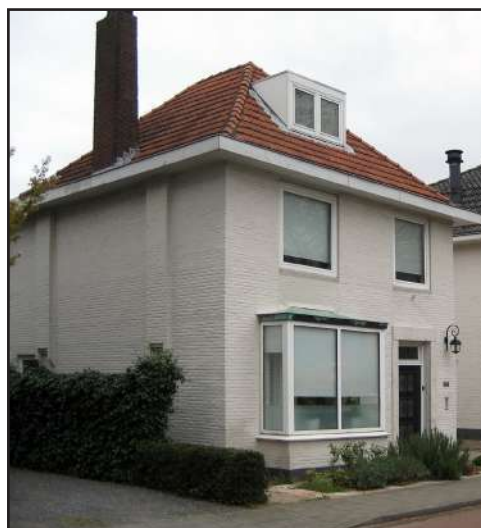
132: Martinus van der Steen, aannemer te Hintham, bouwt hier in 1927 een huis
