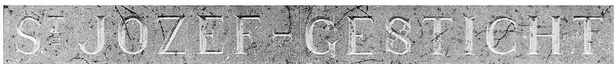
De voorheen aan de gevel bevestigde naam in hardsteen
