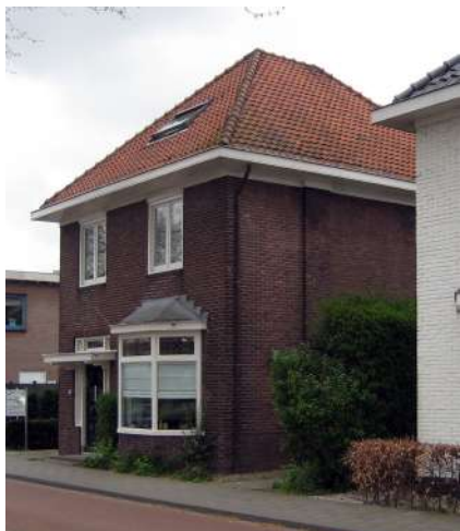
126: Martinus van der Steen, aannemer te Hintham, bouwt hier in 1926 een huis
