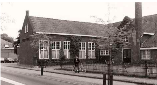
De school in 1990, gezien vanuit het noordwesten. Collectie: Elly van der Plas
