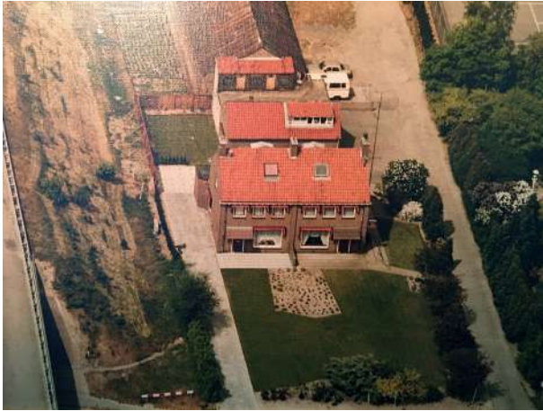
Luchtfoto van de woningen Graafsebaan 2 en 4. Links het talud van de toen smallere A2. Collectie: Frans van Alebeek
