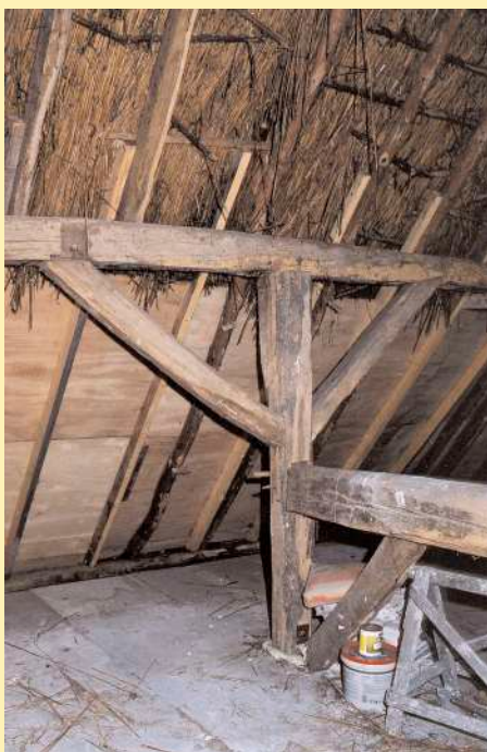
Detail 18e- eeuwse ankerbalkgebint. De balk die horizontaal loopt op de overgang van riet naar houten platen is de fliering. Collectie en foto: BAAC, Archeologie en Bouwhistorie
